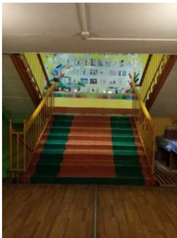
Фото 9. Лестница (внутри здания)
