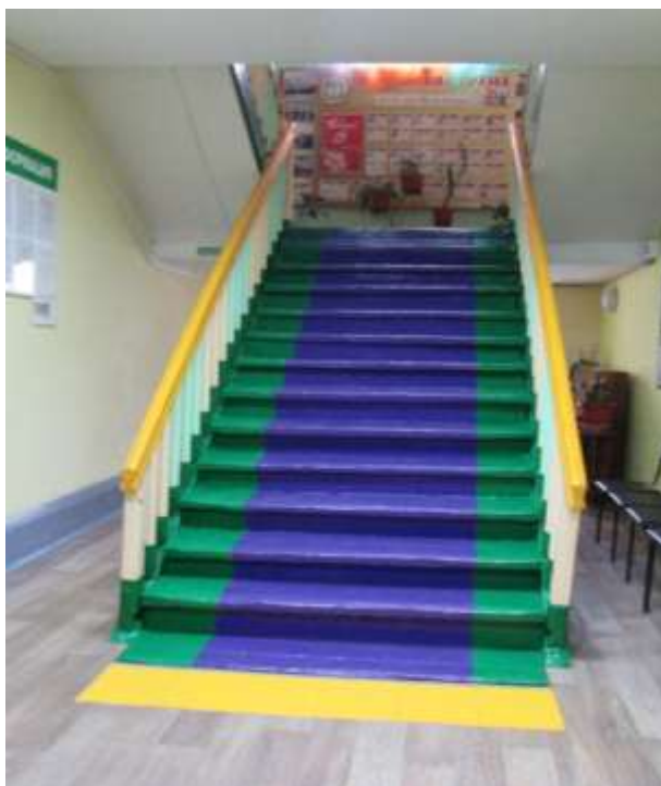
Фото 15. Лестница (внутри здания)
