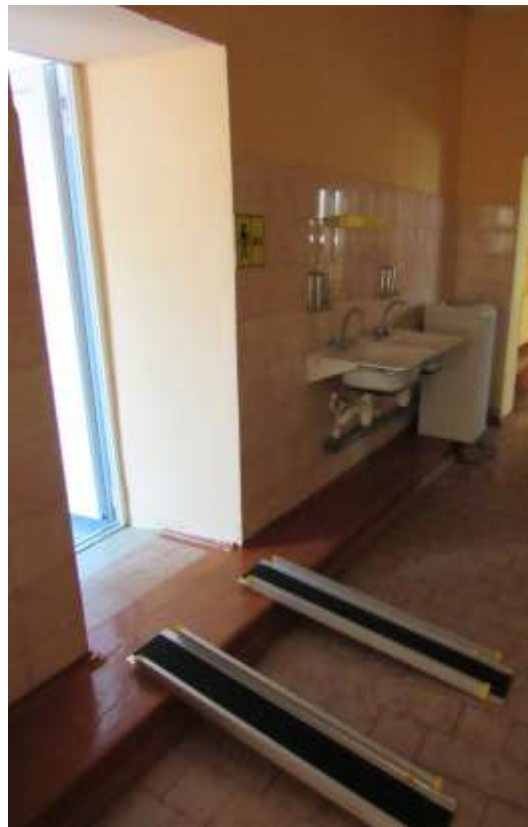
Фото 16-18. Пороговые пандусы односкатные переносные (внутри здания)
